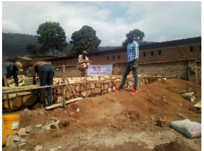
Internaat, start bouw
